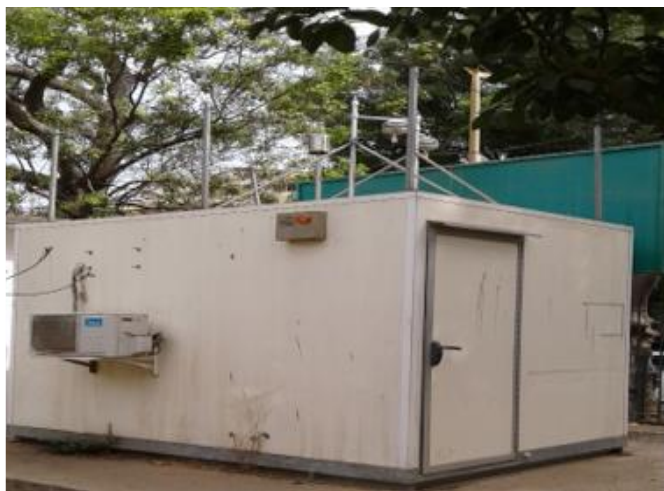
Figure 2 : Vue de l'extérieure d'une station de mesure de la qualité de l'air des HLM (CGQA)
