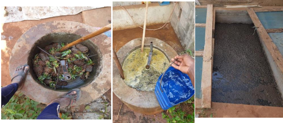
Photo 2 : Chargement du digesteur avec les déchets d'ananas et bouses de vache
