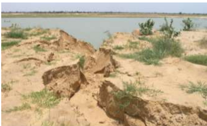
Photo 2 : Étape de mise en place d'une ravine sur la berge du Chari à N'Djaména Prise de vue : Djébé M., août 2014
