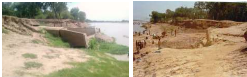
Photo 6 : Dégradation exacerbée des berges par les exutoires des eaux pluviales à N'Djaména Prise de vue : Djébé M., août 2021
