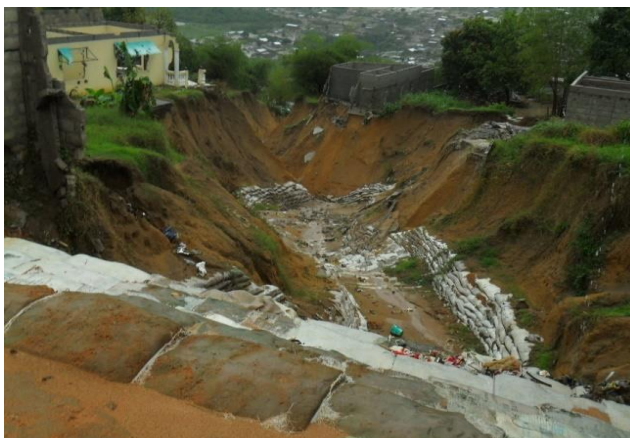
Photo 1 : Erosion à Soukissa
