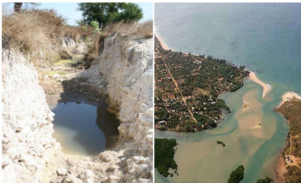
Figure 14 : Sources d'apport sédimentaires dans la lagune de la Somone à gauche une ravine d'épandage et à droite une vue de l'embouchure submergée de bancs de sables [8]
