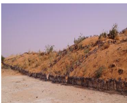
Front de dune fixé par des rachis de palmier doum
