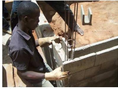
b) Pose des blocs-coffrage des chaînages horizontaux
