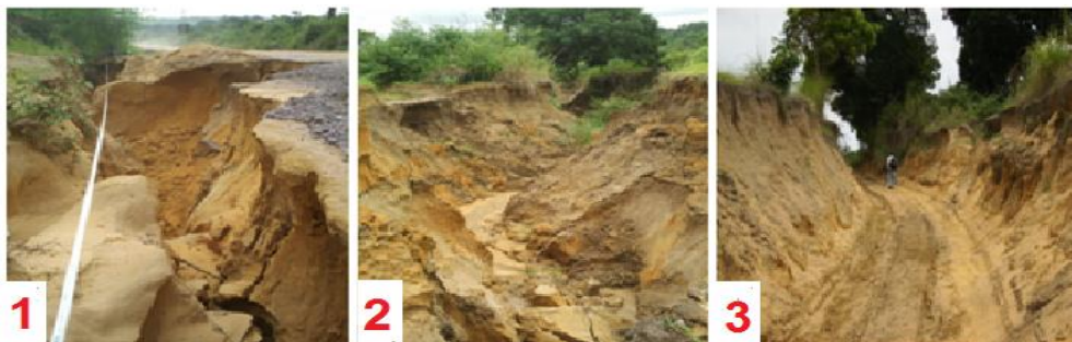
Photo 1 : Ravin linéaire vers Saint Isidore (Linzolo) en 2015 ; Photo 2 : lobe 1 du ravin digité transversal en 2015 à Massissia II ; Photo 3 : surcreusement de route à Mabenga en 2008
