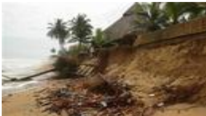
Photo 1 : vue de la plage d'Assinie menacée par l'érosion
