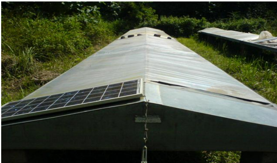
Figure 1 : Séchoir tunnel du type Hohenheim installé dans le canton de Gapé-Kpodji.
